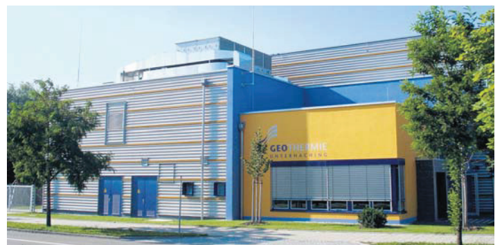
Geothermisches Kraftwerk Unterhaching (Deutschland)
